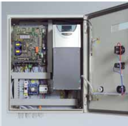
Automatische deuropening via USV. Maakt de weg vrij bij stroomuitval.
